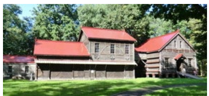
耐震改修された重要文化財「穀物貯蔵庫」
