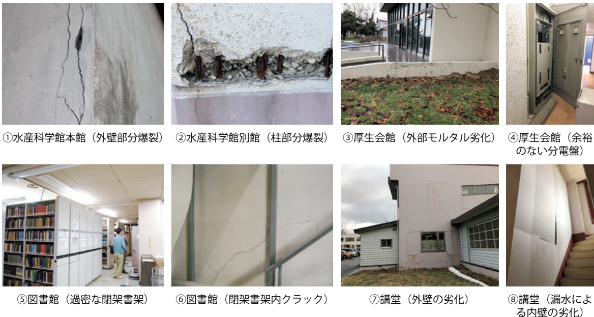
写真 3-3：施設の老朽化状況
