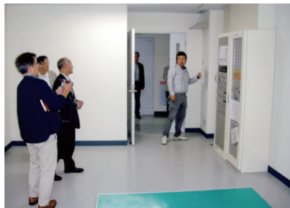
② 専用スペースの確認
