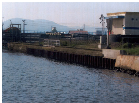
②護岸の状況
