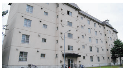
④職員宿舎（梁川団地）
