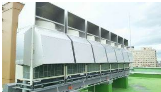
エアコン室外機
