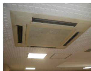
エアコン室内機
