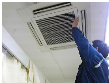
天井埋込の場合：グリルを開きフィルターを外す
