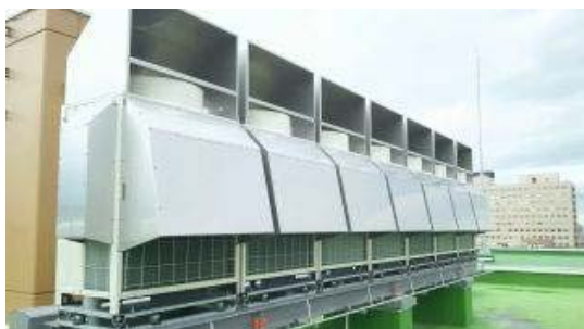
エアコン室外機
