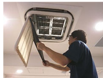
天井埋込の場合：グリルを開きフィルターを外す
