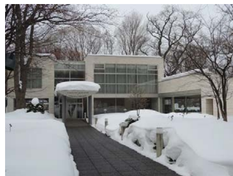
ロードヒーティング設備
