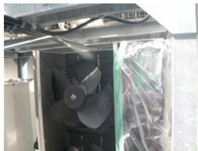
室外機洗浄の様子
