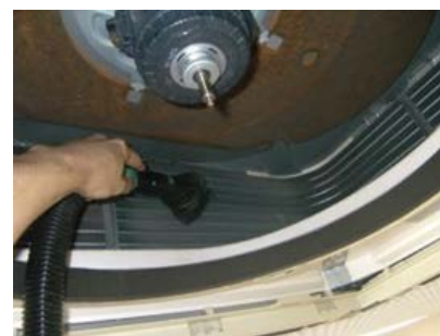
室内機洗浄の様子
