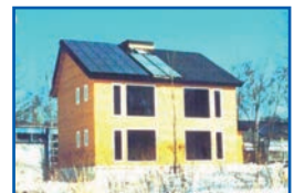
4 実験住宅「ローエネルギーハウス」
