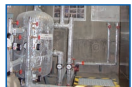
6 地熱融雪設備
