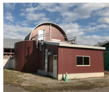
バイオガス発電施設
