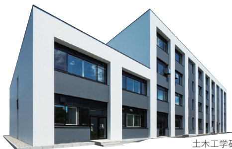
土木工学研究棟 ■建築面積/1,385㎡ ■延べ床面積/4,392㎡ ■構造・階数/RC造地上4階
