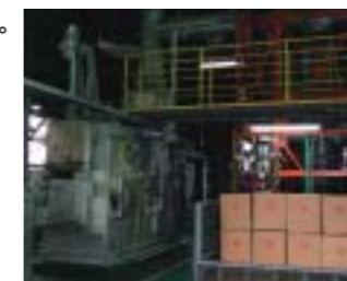
有機系廃液処理施設(北見市)
