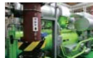
高効率冷凍機
