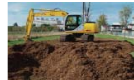
木チップ敷き均し状況
