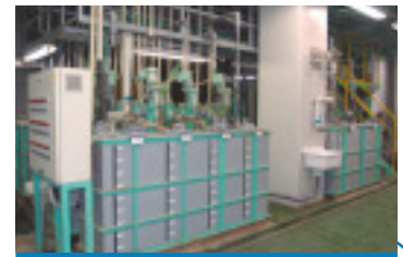
1 環境保全センター (無機系廃液処理設備)
