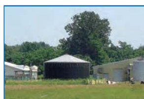
⑬ バイオガスプラント
