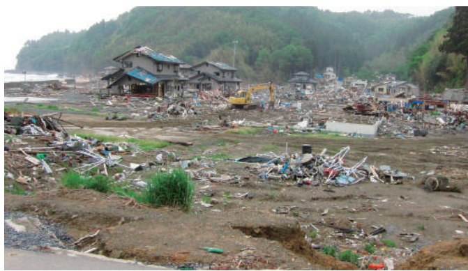
壊滅的な被害を受けた石巻市北土町
