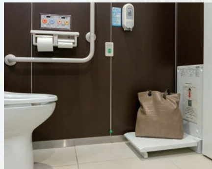
エルムの森 多目的トイレに設置されたフィッシングボード
