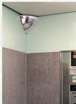
教育学部研究棟のエレベーターに設置された三角ミラー
