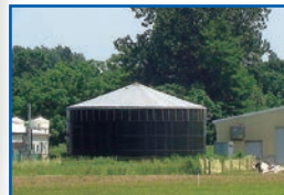
③ バイオガスパラント
