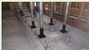
地盤アンカー設置状況
