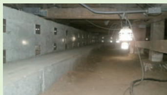
補強基礎設置状況
