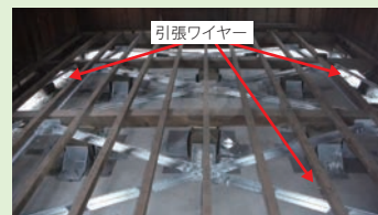
新設基礎設置状況
