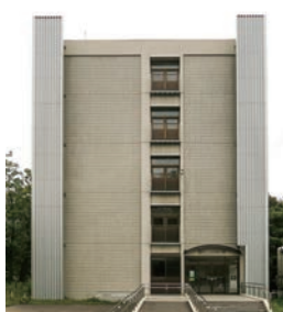
中央キャンパス総合研究棟2号館
