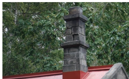
モデルバーン釜場(煙突石積みズレ)
