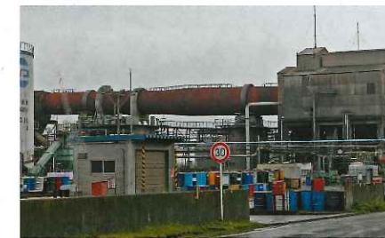
有機系廃液処理施設（苫小牧市）
