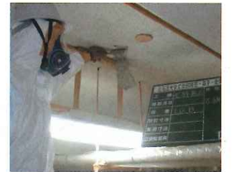
アスベスト除去状況
