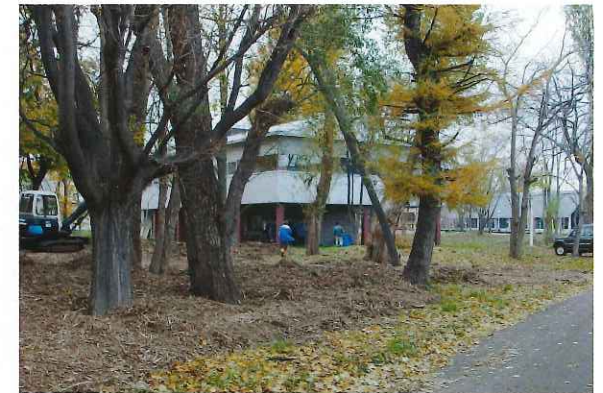
木チップの敷き均し
